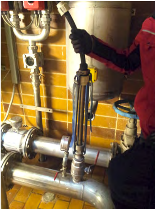
Abbildung 59: Einschwemmverfahren / Einziehen des Stahlseils.
