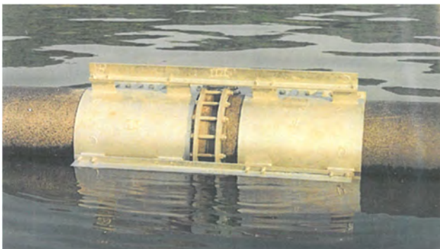
Abbildung 7: Mit Hilfe einer Metallkonstruktion biegesteif gesicherte Verbindung (Bildquelle: Links: Flanschverbindung beim Attersee, Rechts: Spiegelschweißung beim Ossiacher See).
