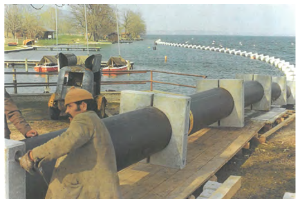
Abbildung 14: Links: Positionierungsgewichte (Bildquelle: WV Ossiacher See); Rechts: Montage der Beschwerungsgewichte Mai 1975 (Bildquelle: RHV Attersee).
