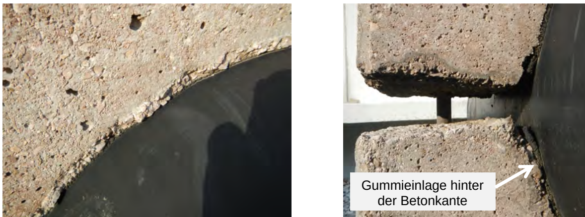
Abbildung 71: Anbringen der Betonklötze am Rohr. Hier ein Ausstellungsstück des RV Attersee aus den 1970er Jahren (Bildquelle: Ortsbegehung Attersee).
