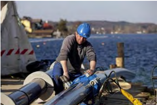
Abbildung 82: Endmontage und Lagerung der 2,6 km langen Trinkwasserleitung im Attersee im Jahr 2009 (URL: http://www.energieag.at/ [20.07.2015]).
