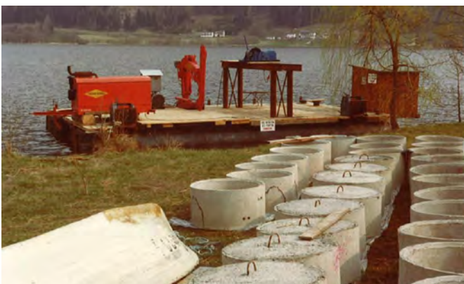
Abbildung 14: Links: Positionierungsgewichte (Bildquelle: WV Ossiacher See); Rechts: Montage der Beschwerungsgewichte Mai 1975 (Bildquelle: RHV Attersee).
