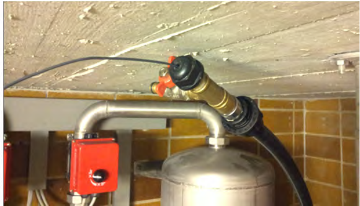
Abbildung 59: Einschwemmverfahren / Einziehen des Stahlseils.
