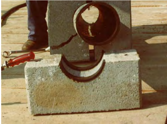
Abbildung 15: Montage der Beschwerungsgewichte; Links: Gummieinlagen in den Betonhalbschalen und Befestigung mit verzinkten Schrauben (Bildquelle: WV Ossiacher See); Rechts: Metallbänder um runde Betongewichte (Bildquelle: Ortsbegehung Faaker See)
