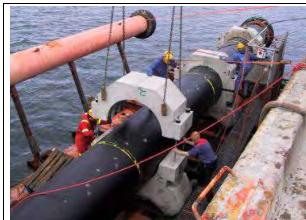
2001: Seeausleitung in Reykjavik, Island – \varnothing 1400 mm ( L = 5.690 m), \varnothing 1200 mm ( L = 155 m) und \varnothing 1000 mm ( L = 400 m)
