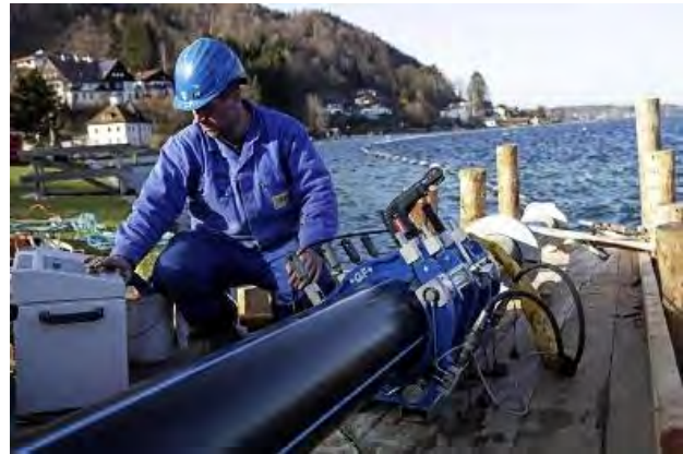
Abbildung 82: Endmontage und Lagerung der 2,6 km langen Trinkwasserleitung im Attersee im Jahr 2009 (URL: http://www.energieag.at/ [20.07.2015]).
