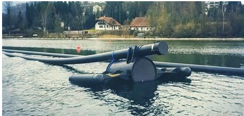
Abbildung 83: Produktion und Lagerung der 6,5 km langen Trinkwasserleitung im Traunsee im Jahr 1998 (Bildquelle: AGRU Kunststofftechnik GmbH).
