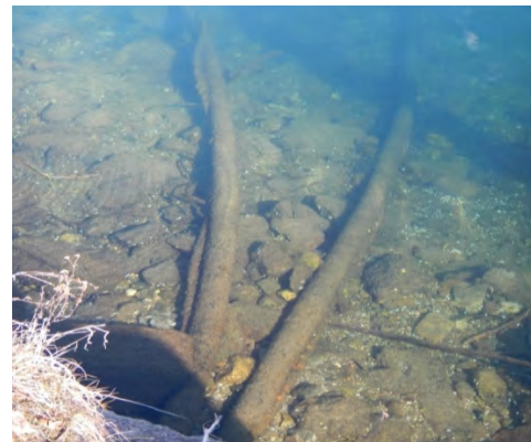
Abbildung 13: Alternative Beschwerungsgewichte für SDL mit kleineren Durchmessern. Links: Schelle auf Beton/Stahl (Bildquelle: AWWA Manual M55, 2006), Rechts: mit einem Stahlseil spiralförmig umwickeltes PE-Rohr (Bildquelle: Ortsbegehung Millstätter See).
