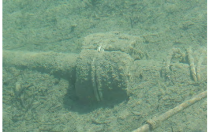
Abbildung 15: Montage der Beschwerungsgewichte; Links: Gummieinlagen in den Betonhalbschalen und Befestigung mit verzinkten Schrauben (Bildquelle: WV Ossiacher See); Rechts: Metallbänder um runde Betongewichte (Bildquelle: Ortsbegehung Faaker See)
