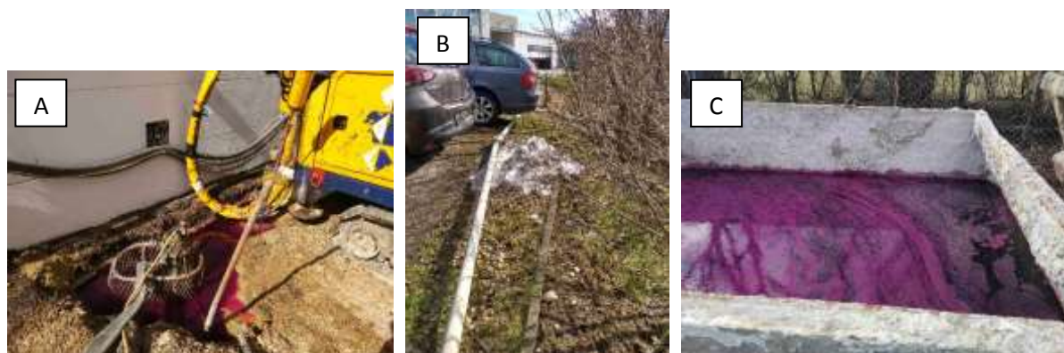
Abbildung 60: A: Pumpe zum Abpumpen der Rücklaufsuspension aus der Auffangkünette. B: Leitung zwischen Auffangkünette und Mulden zur Sammlung des Rücklaufes. C: Mit Rücklaufsuspension befüllte Mulde.
