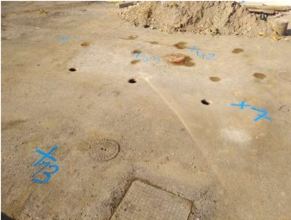
Abbildung 70: Markierungen für Sondierungspunkte für die MIP-Sondierung nach der 2. Jet-Kampagne.
