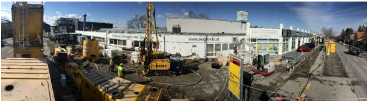
Abbildung 57. Panoramafoto der Baustelleneinrichtung
