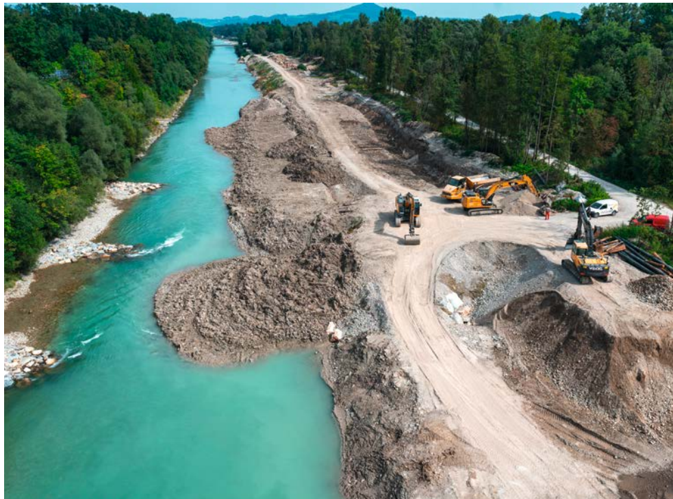
Abtrag der bestehenden Ufersicherungen, Freimachung des erweiterten Flussraumes und verlegter Treppelweg rechtsufrig im Bauabschnitt 3
