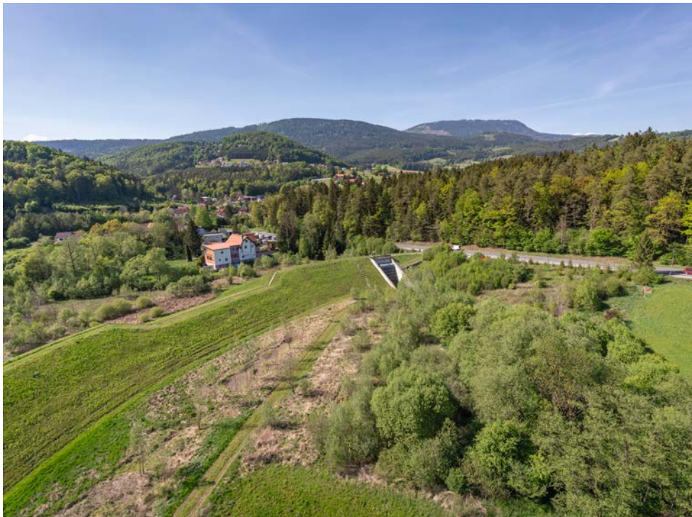
Bereits hergestelltes Hochwasserrückhaltebecken flussabwärts des 4. Bauabschnitt
