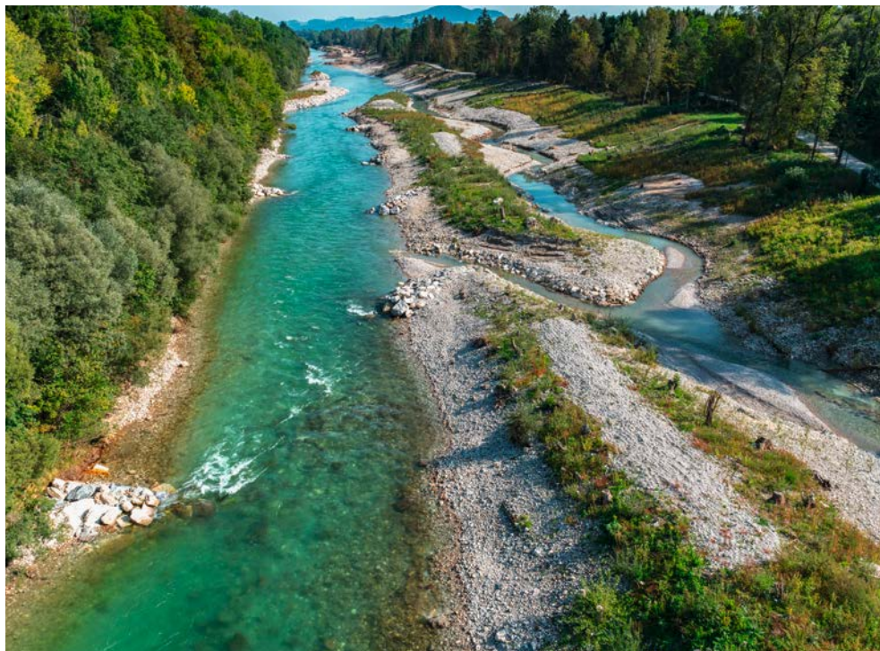
Saalach mit aufgeweitetem Gewässerbett, neu angelegtem Seitenarm und naturnah gestaltetem rechtem Ufer im Bauabschnitt 1
