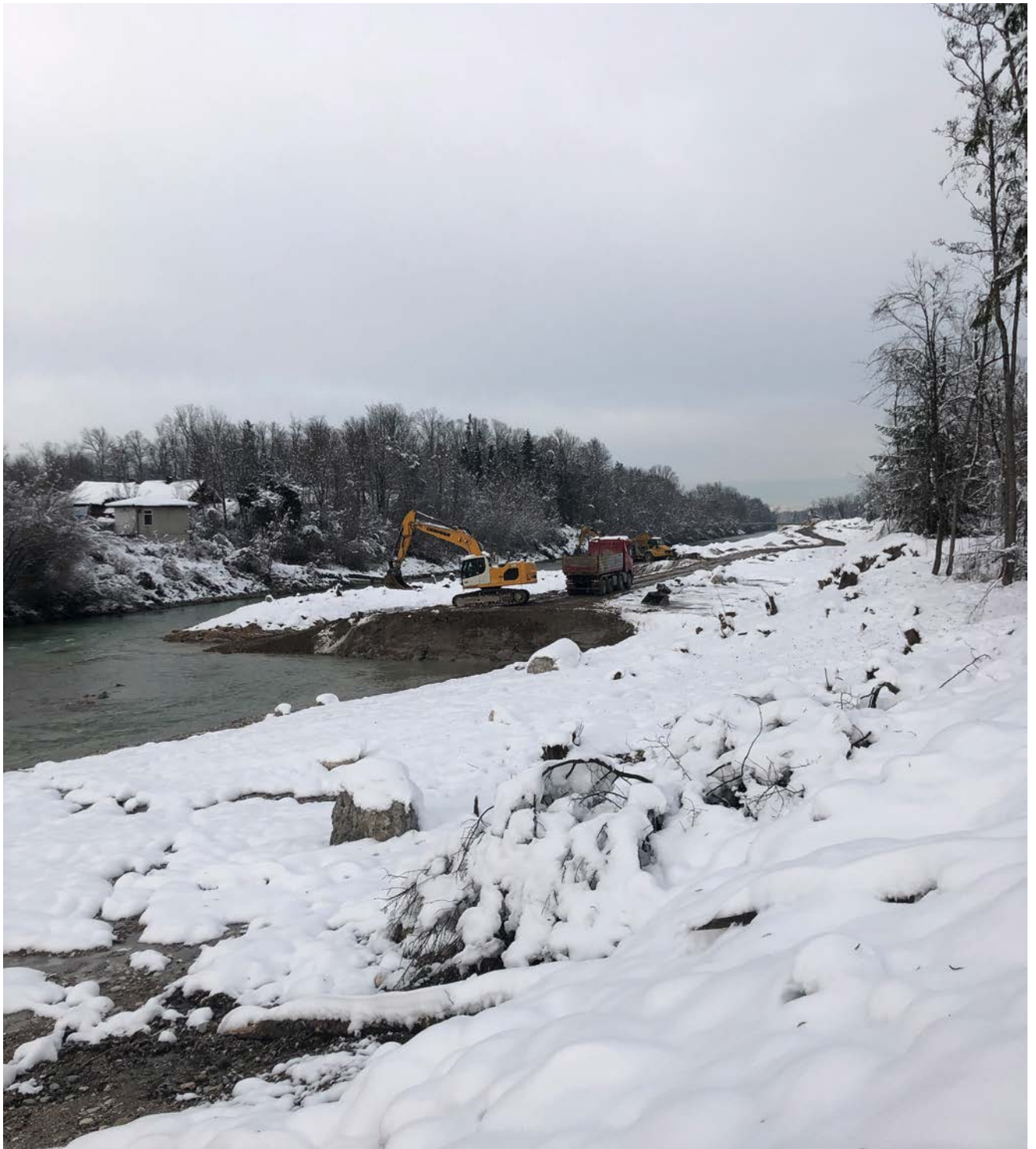
Aushubarbeiten im Aufweitungsbereich des Bauabschnittes 3 im Dezember 2023
