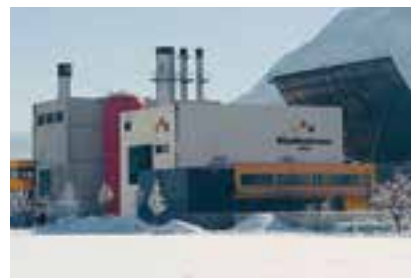
Heizwerk der Stadtwärme Lienz
