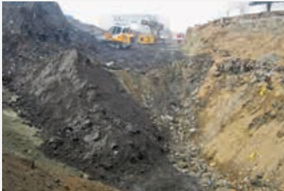
Räumung des kontaminierten Materials
