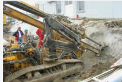
Injektion unter die bestehenden Bebauung
