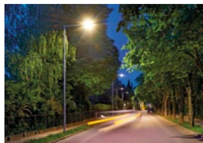
Die Stadtgemeinde Gänserndorf stellte die Straßenbeleuchtung auf LED um
