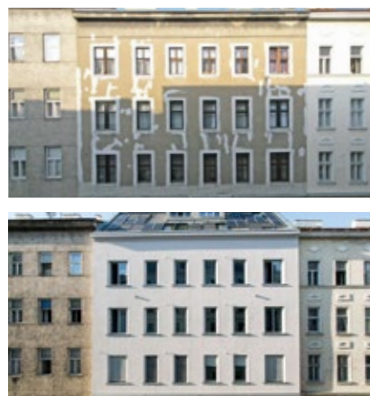
Sanierung Gründerzeitgebäude Vergleich vorher/nachher
